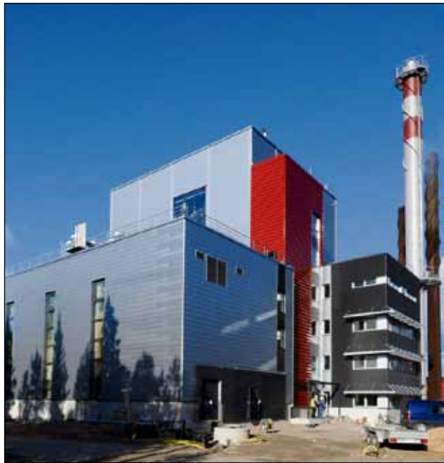
Nivalan Kaukolämpö Oy Voimalaitos Kuvaaja Markku Ollakka.
